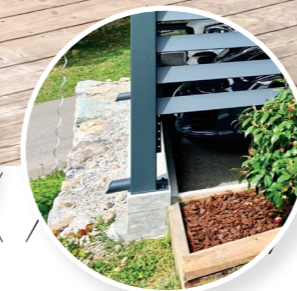
Maçonnerie adaptée à la topographie du terrain
