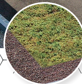
Gestion de l'eau pluviale avec plantes sédum
