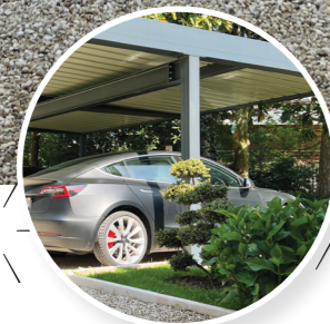
Déport des poteaux pour des manœuvres facilitées
