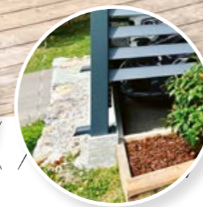
Maçonnerie adaptée à la topographie du terrain
